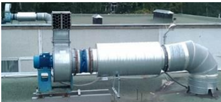
Рисунок 6.2 – Штучна (механічна) вентиляція
