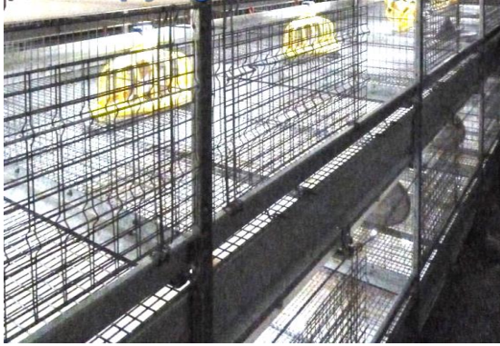
Рисунок 9.4 Розташування світильників у системі кліткового утримання курей.
