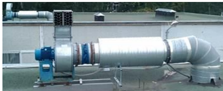
Рисунок 4.1 – Механічна (Штучна) вентиляція
