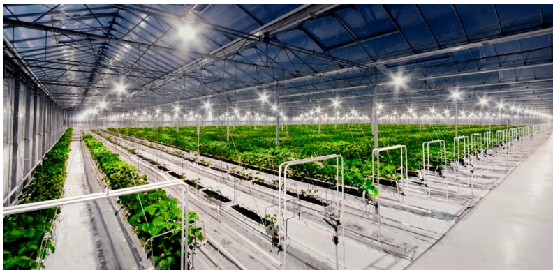
Рисунок 9.7 – Освітлення теплиці
