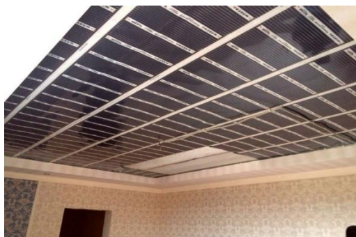
Рисунок 2.7 – Стельовий монтаж інфрачервоної плівки
