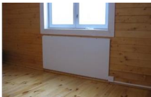
Рисунку 2.8 – Настінна інфрачервона керамічна панель обігріву приміщення
